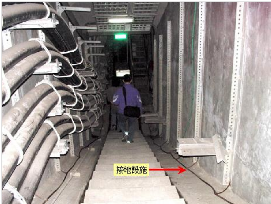
圖十三 共同溝系統接地設施
