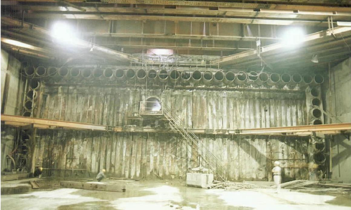
圖十一 本工程隧道段管幕完成圖
