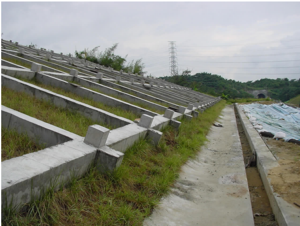
照片一 土釘及格梁護坡
