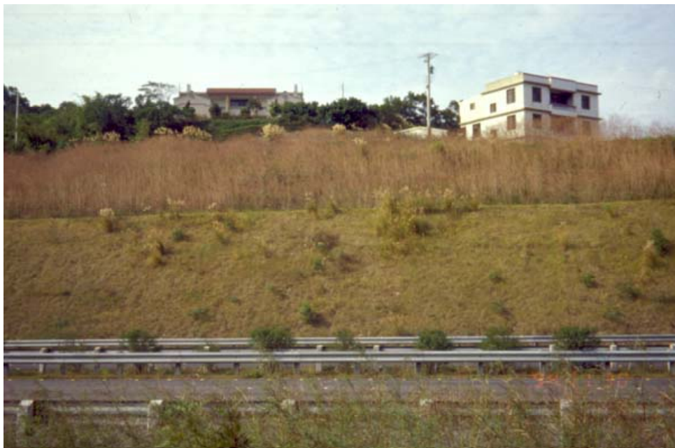
照片 2. 土牆邊坡完工後情形
