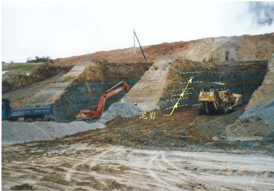
照片 1. 土牆分段式跳島開挖施工情形(深灰色部分為泥岩)
