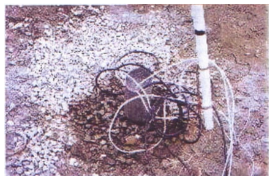
照片3.2 炸震夯實工法現場施工狀況(2)
