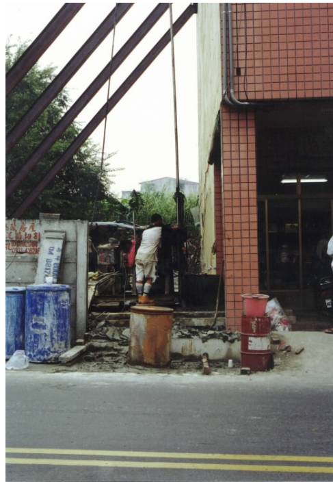
照片4.3 員林惠明街建物以型鋼支撐及灌漿情形
