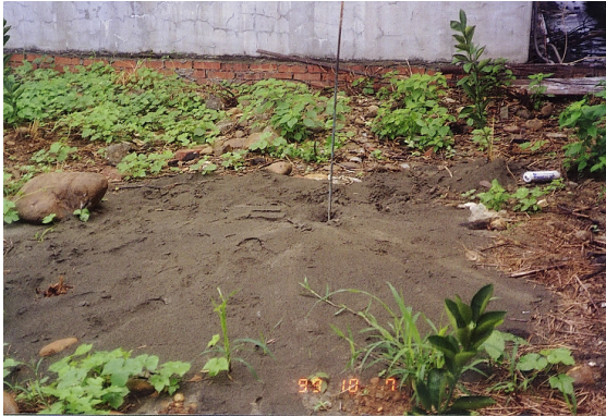
照片2.3 員林液化造成屋旁空地噴砂
