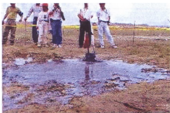
照片3.2 炸震夯實工法現場施工狀況(1)
