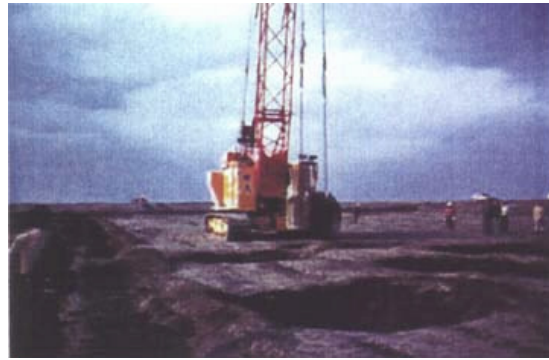
照片3.1 動力夯實工法現場施工狀況
