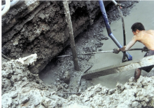
照片4.1 員林民生路建物以高壓水柱 沖洗基礎底部土壤
