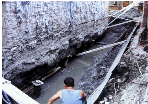
照片4.2 員林民生路建物於基礎底版下方 放置千斤頂
