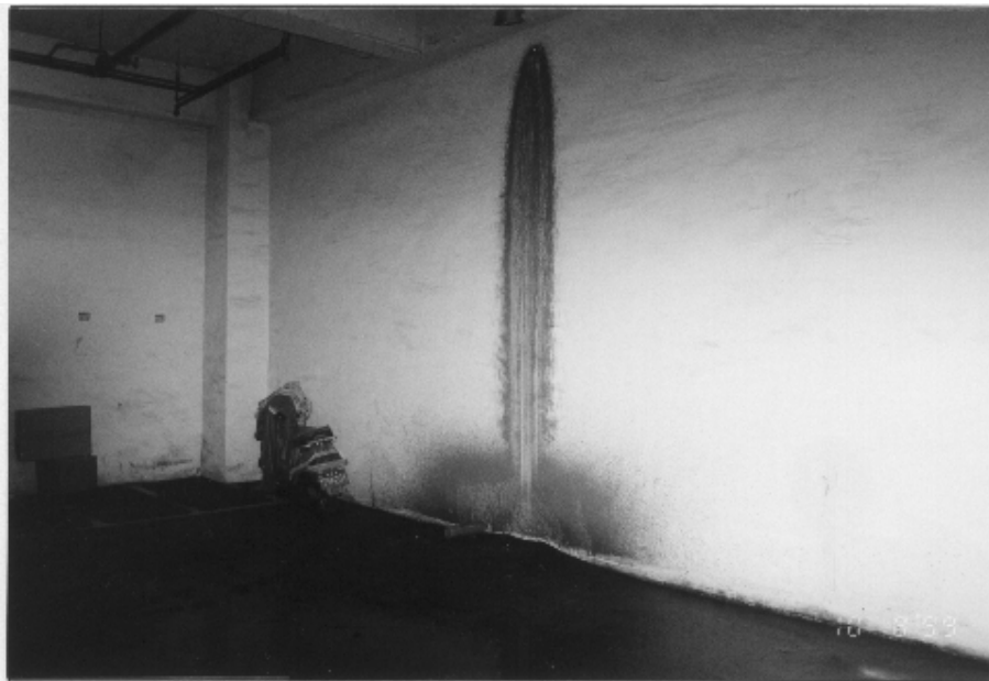
案例3 國富鎮集合住宅地下室噴砂後留在牆上之痕跡
