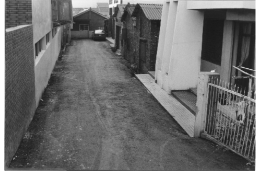
案例6 鋪面龜裂嚴重，兩側建物傾斜沉陷，路面已重鋪復建，但仍可鋪面兩側與建物交接處看出沉陷之痕跡
