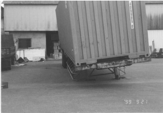
案例11-2 空地因土壤液化失去承載力，致使貨櫃之支撐貫入土中
