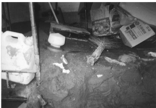
案例10-1 三合院屋內噴砂嚴重，灰黑色細砂堆積高度約一公尺
