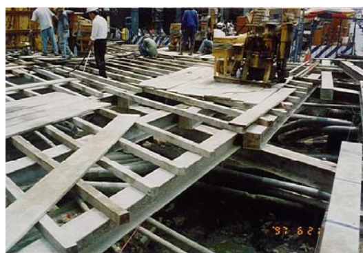
照片一 大量管線妨礙地盤改良作業
