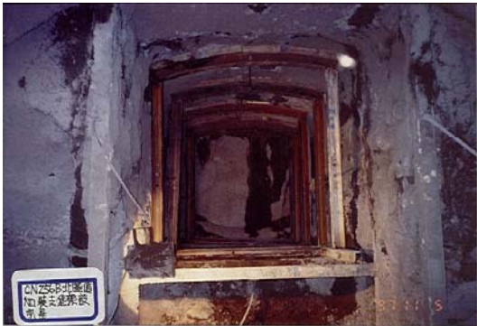
照片二 隧道IA階段開挖
