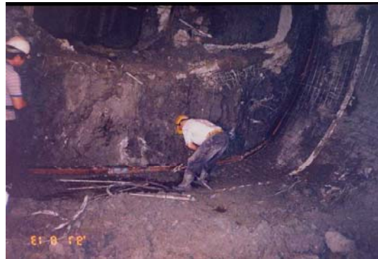
照片五 隧道III階段開挖
