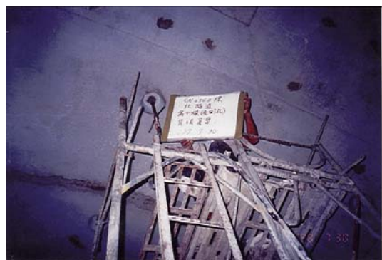
照片十一 內襯砌背填灌漿施工
