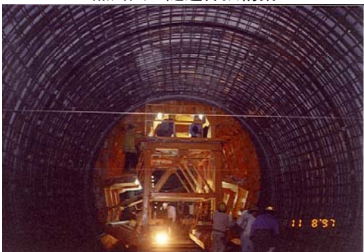
照片九 隧道上部內襯砌構築
