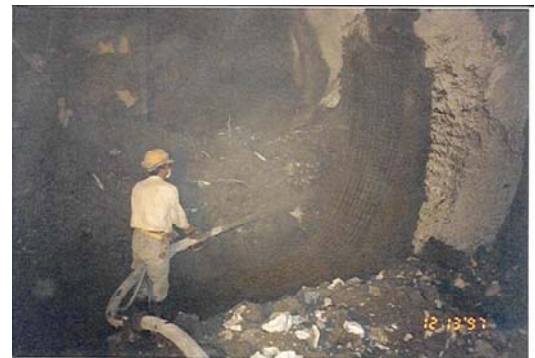
照片七 隧道噴凝土施工
