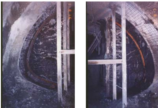
照片四 隧道II階段開挖
