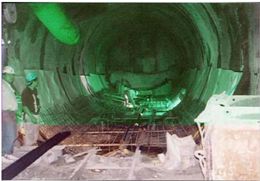
照片八 隧道仰拱構築
