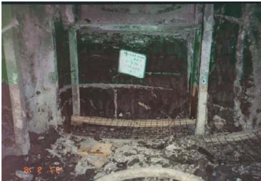
照片三 隧道IB階段開挖
