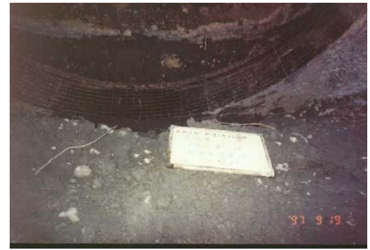
照片六 隧道IV階段開挖
