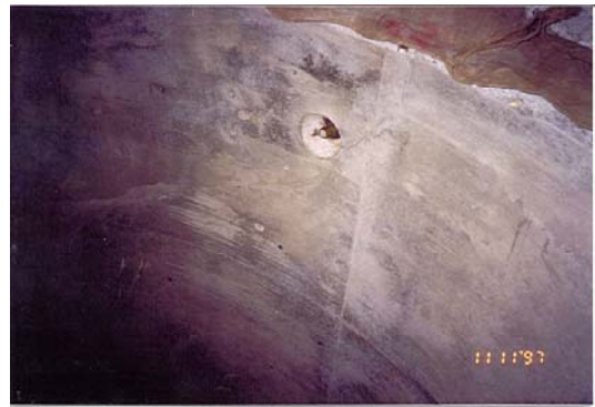
照片十 內襯砌預留背填灌漿孔
