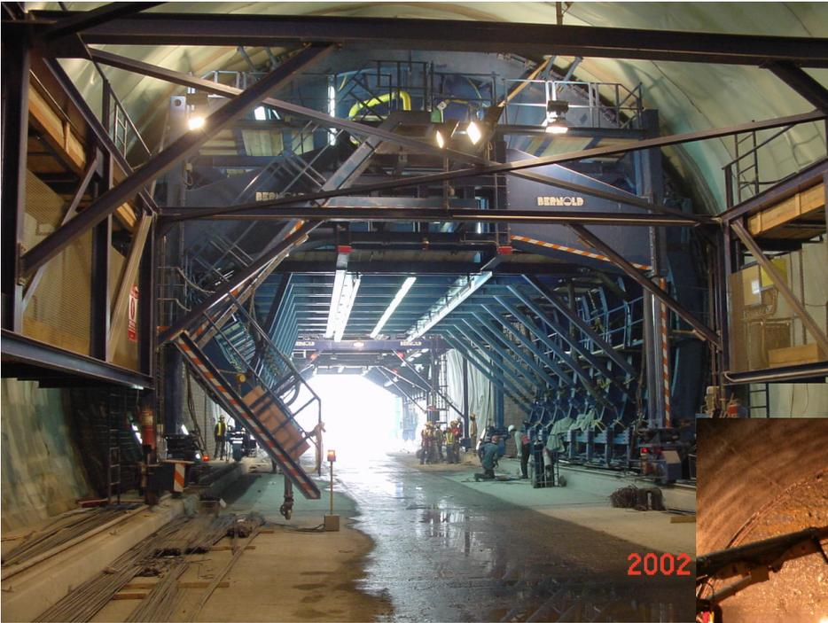
台灣高速鐵路 C260 標八卦山隧道南洞口附近內襯砌施工情形
