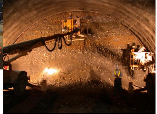
台灣高速鐵路 C260 標八卦山隧道卵礫石層開挖支撐情形
